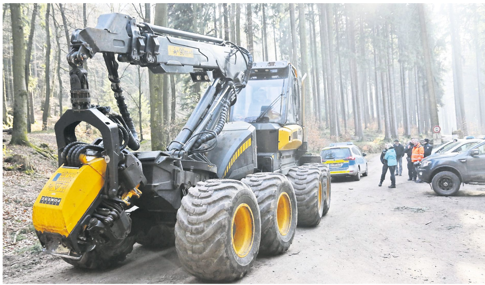
Begleitet von einem großen Polizeieinsatz und dem Protest der Windkraftgegner begannen gestern die Rodungsarbeiten für den geplanten Windpark im Gebiet „Stillfüßel“ bei Wald-Michelbach.
